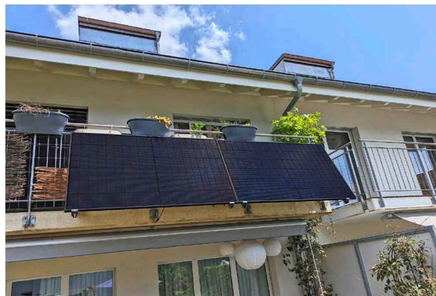
So sieht eine Plug & Play-PV-Anlage mit zwei Solarmodulen aus.
